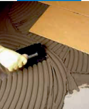
Nanášení Elastorapidu zubovou stěrku na cementový potěr
