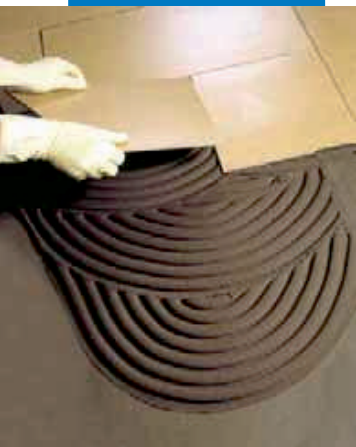
Pokládka keramické dlažby na potěr izolovaný Mapelastice
