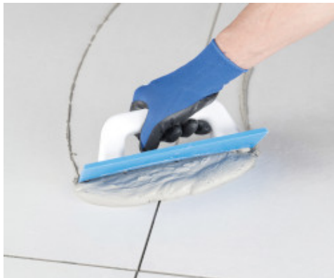
Nanášení Ultracoloru Plus gumovou stěrkou
